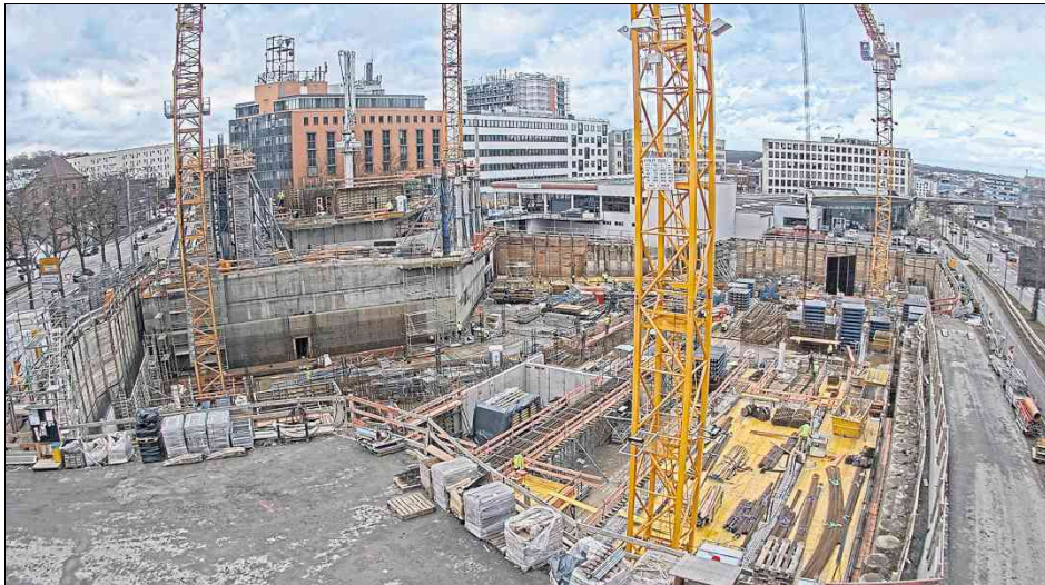
Momentan wird das zweite Tiefgaragengeschoss für das Porsche-Zentrum errichtet.
