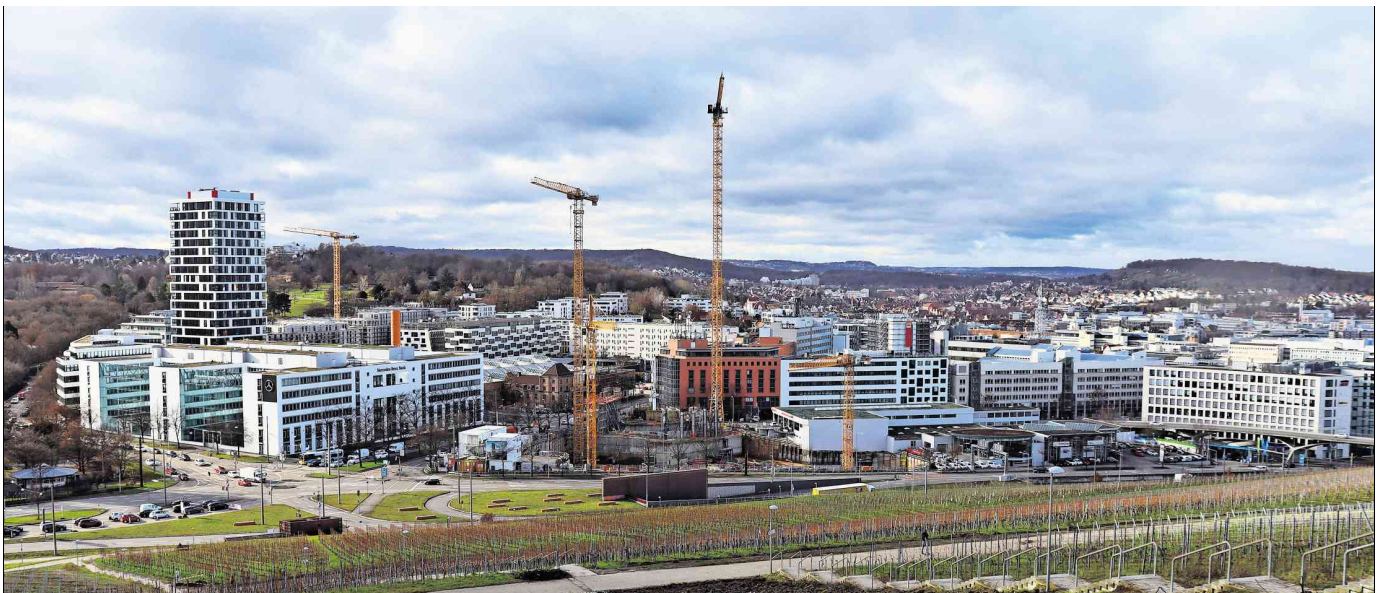
Die Kräne auf dem Pragsattel sind von weitem zu sehen. Die Bauarbeiten für den Porsche-Tower liegen im Zeitplan.
